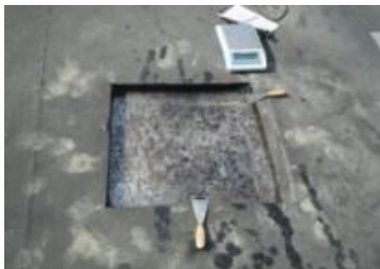
图 9.7 切除原有损坏铺装
