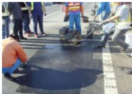
图 9.10 整平的修补铺装
