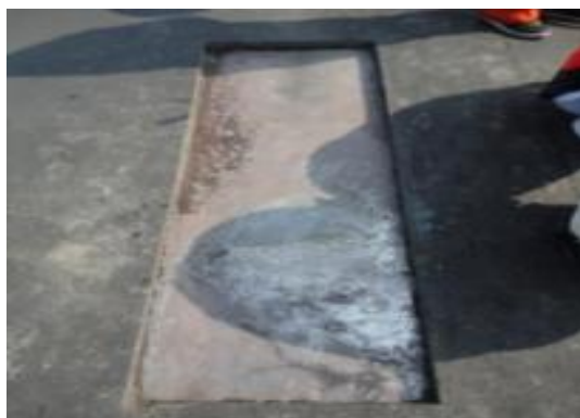
图 9.2 切除损坏铺装
