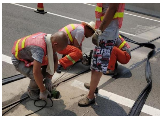
图 9.13 伸缩缝橡胶条更换
