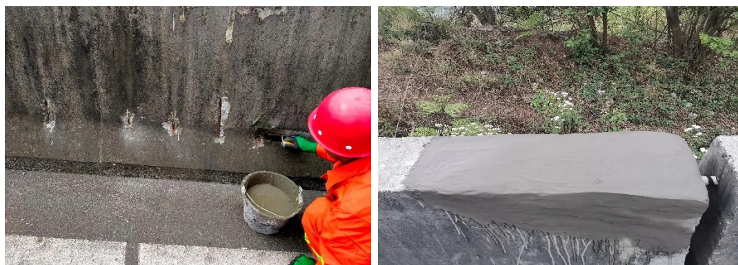
图 9.14 混凝土护栏修补
