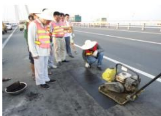
图 9.5 整平的修补铺装
