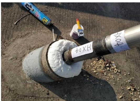
图 6.11 索导管填充发泡材料
