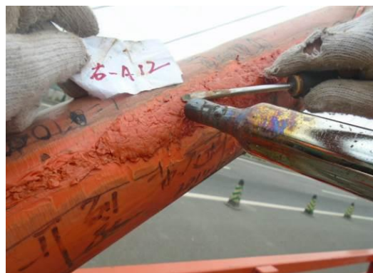
图 6.2 PE 护套修补
