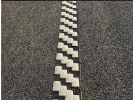
图 7-5 新型振动型边缘线
