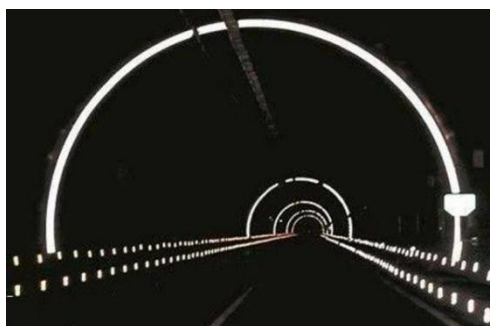
图 7-2 无照明普通公路隧道轮廓带现场图
