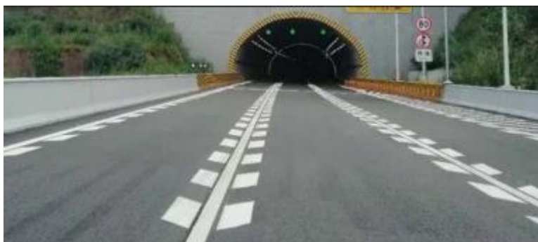
图 5-4 纵向减速标线现场图
