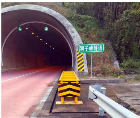
图 6-1 隧道入口可导向防撞垫
